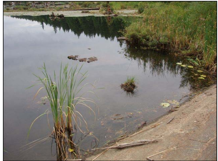
Top of Langley Lake Spill
